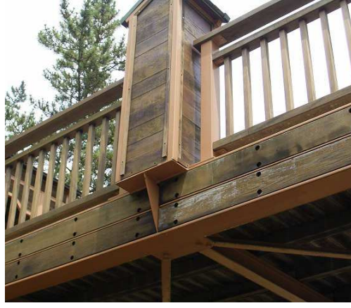
塗膜残存と脱落の混在
